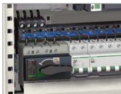
Partenza dispositivi Linergy FM 80 A.
