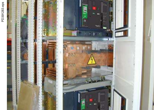
Sistema di commutatori di rete nello stesso armadio.
